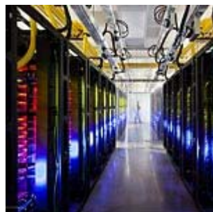
A Peephole for the N.S.A.
